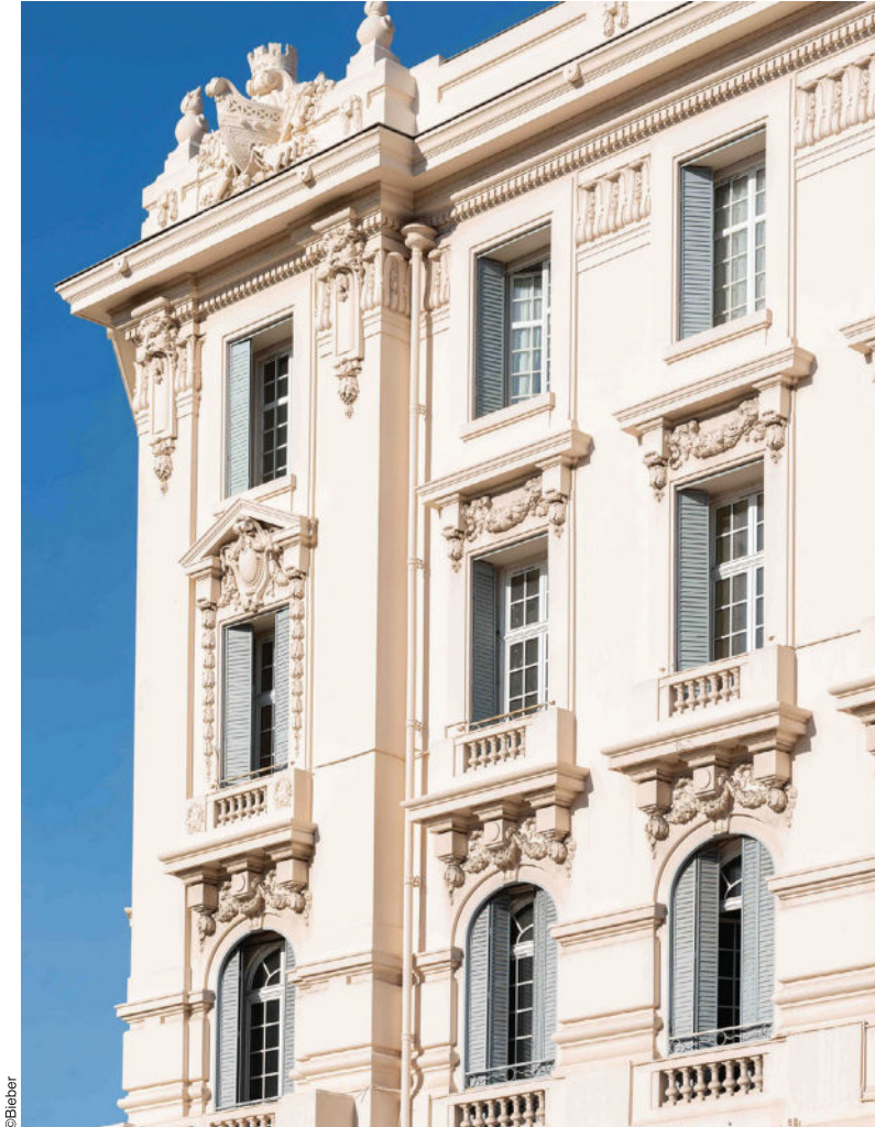
Ici, le Grand hotel d'Antibes (06) a été réhabilité en 36 appartements de standing avec la même gamme Inova de Bieber en 68 mm avec laquage RAL 9016 garanti 10 ans.
