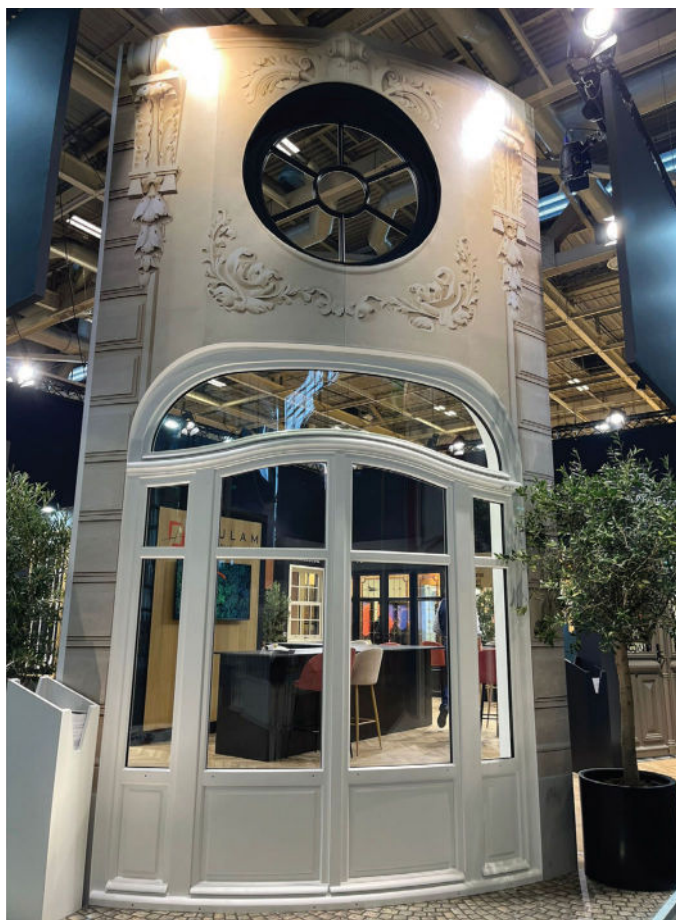
Témoin du savoir-faire d'Atulam, cette fenêtre cintrée en plan avec vitrage bombé était exposée sur son stand au dernier salon Batimat.
