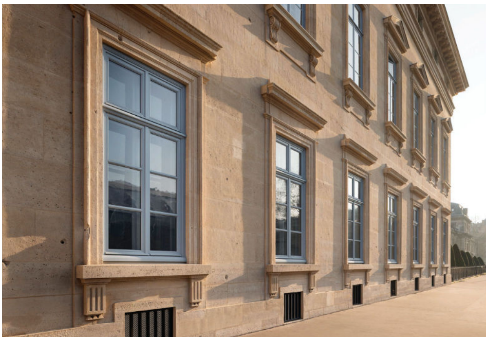
Daucalis : renforcement de la sécurité des bâtiments de l'École Militaire à Paris ouvrant sur le Champ-de-Mars. Fabrication et pose de 32 menuiseries extérieures bois en retard effraction classe RC4.
