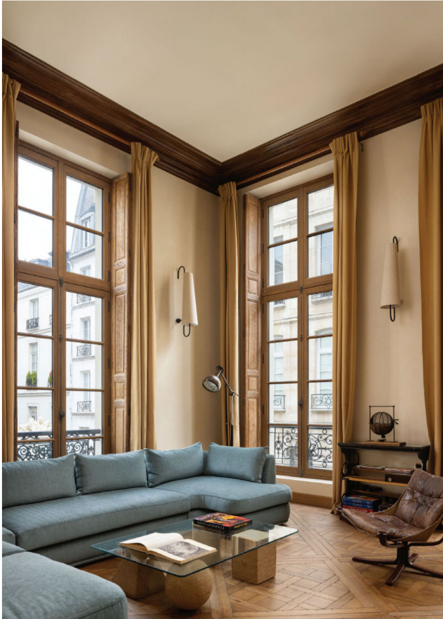
Daucalis : fabrication et pose de 17 menuiseries avec affaiblissement acoustique de 42 dB Ratr et réemploi de volets intérieurs restaurés pour un appartement privé.
