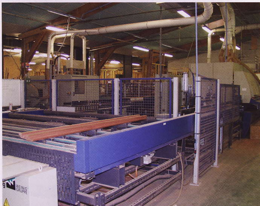
La ligne d'usinage Weinig installée en 2006.
