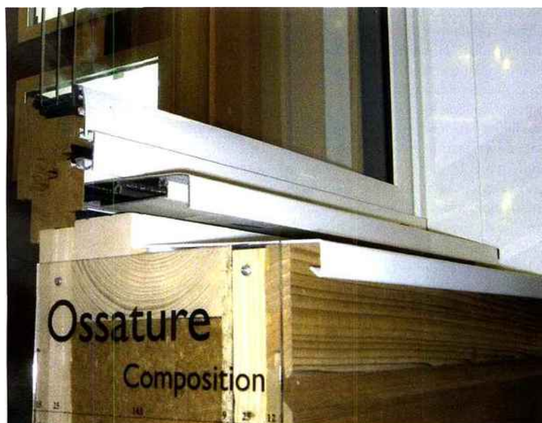
Minco exposait le modèle d'adaptation de ses fenêtres mixtes sur une ossature bois.
